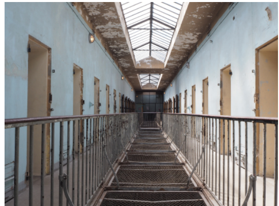
4. 2 ème étage du bâtiment cellulaire, aile des condamnés. © Mémorial National de la prison de Montluc
