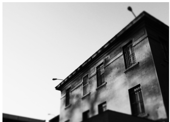
6. Détail du bâtiment cellulaire vu de la cour de promenade © Mémorial National de la prison de Montluc
